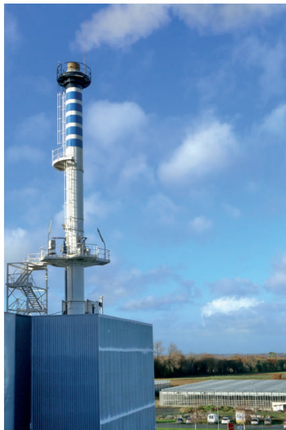
Cheminée de l'UVE
